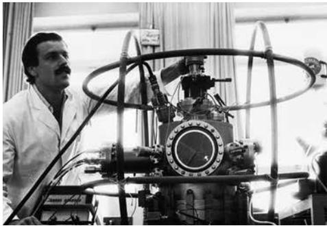
Grenzflächenforschung 1978: ein Mitarbeiter an der Ultrahochvakuum-Apparatur zur Messung der Sauerstoffanreicherung auf Eisenkristallobertflächen.
